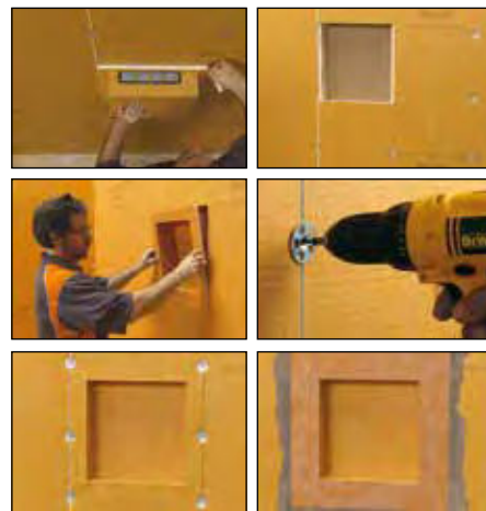
Mise en œuvre sur KERDI-BOARD
