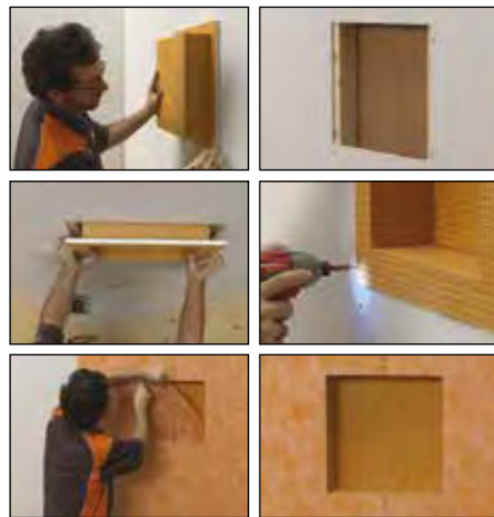
Mise en œuvre sur plaques de plâtre
